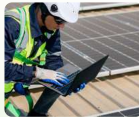
ติดตั้งพลังงานสะอาด (Solar PV) ให้กับคู่ค้า
