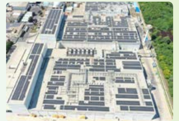
ติดตั้ง Solar Rooftop กำลังไฟฟ้า 5 MW สามารถลดก๊าซเรือนกระจกได้ 90,000 ตัน CO 2 e
