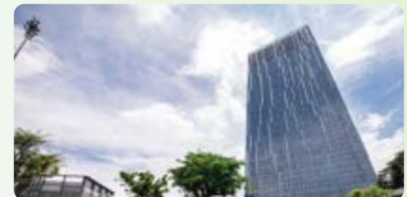
รางวัลความภาคภูมิใจ: ได้รับรางวัล New and Existing Building และ Winner of the Energy Efficient Building-new and Existing Building of the ASEAN Energy Efficiency and Conservation Best Practices Awards 2023
