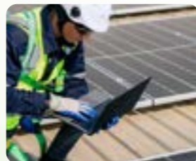
ติดตั้งพลังงานสะอาด (Solar PV) ให้กับคู่ค้า
